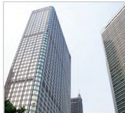
成都棕榈泉国际中心 Chengdu Palm Springs International Center 地点(Place) : 成都 Chengdu 面积(Area) : 50000m 2 地板类型(Panel Type) : OA网络地板
