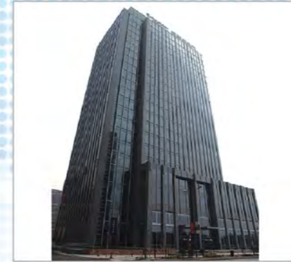
上海长丰大厦 Shanghai Changfeng Building 地点(Place) : 上海 Shanghai 面积(Area) : 22000m 2 地板类型(Panel Type) : OA网络地板
