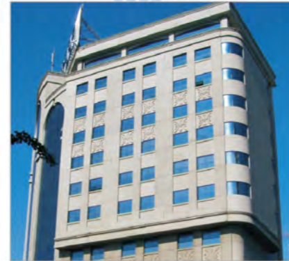
北京电信通信指挥楼 China Telecom (Beijing) Office Building 地点(Place) : 北京 Beijing 面积(Area) : 15000m 2 地板类型(Panel Type) : HPL防静电地板
