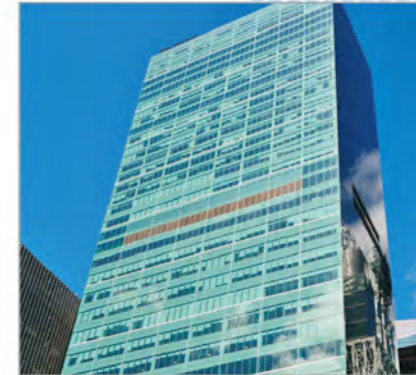
南昌绿地新都会 Nanchang Greenland Center 地点(Place) : 南昌 Nanchang 面积(Area) : 20000m 2 地板类型(Panel Type) : 新型线槽网络地板
