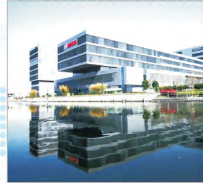
上海博世研发中心大楼 Bosch Shanghai Research Center 地点(Place) : 上海 Shanghai 面积(Area) : 27000m 2 地板类型(Panel Type) : OA网络地板
